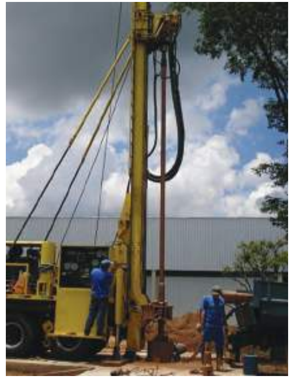
liberar a caixa de mordentes inferior e continuar com a perfuração
