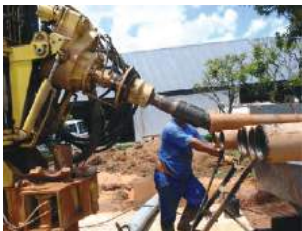
Articulação do cabeçote para acoplamento de uma haste de perfuração Fig. 19B
